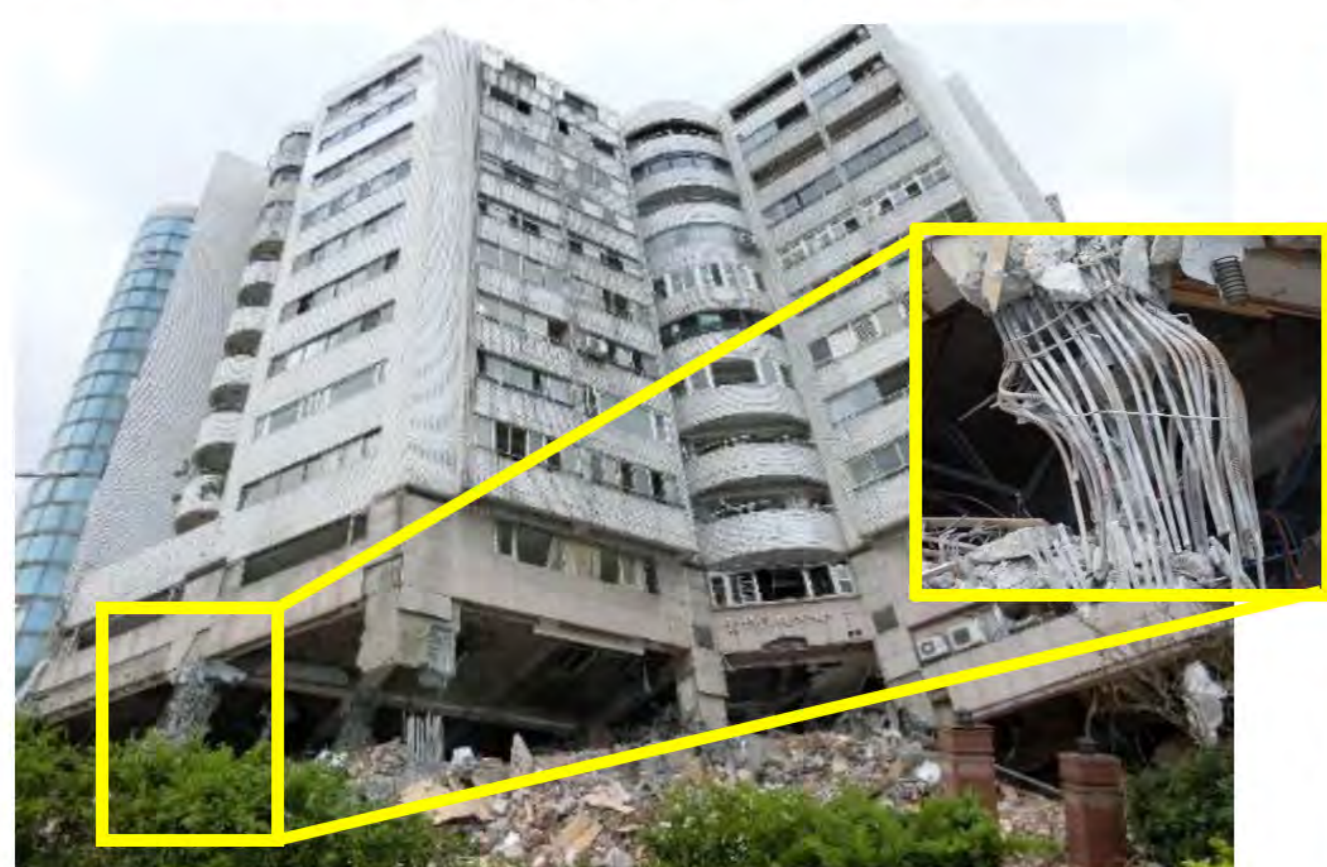
地震による倒壊建物と柱の破壊 傾斜した建物
