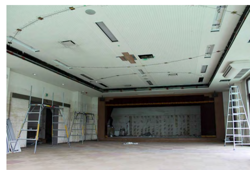
ケーブルによる天井の補強
