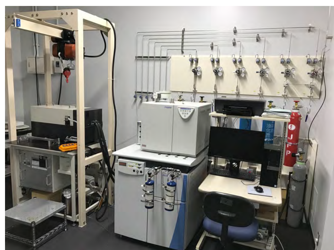
同位体実験室 質量分析計やレーザー分光計など各種実験機材も完備。
