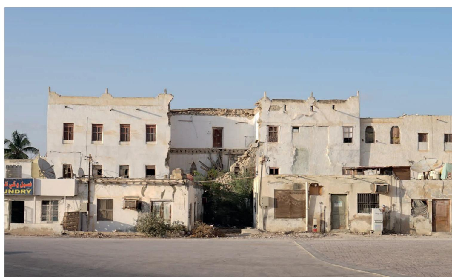
アラビア半島のオマーンで進めている石造家屋の修復プロジェクトです。中緯度乾燥地域のオマーンは木材資源に乏しく、今までこそコンクリートの住宅が主流になっていますが、かつては石や土を中心でした。その構法を解明しながら、サイクロンで損壊した住宅を現代によみがえらせる取り組みです。
