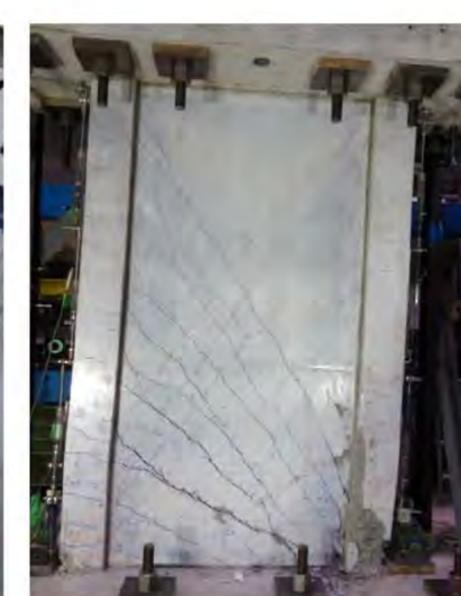
最終破壊状況
