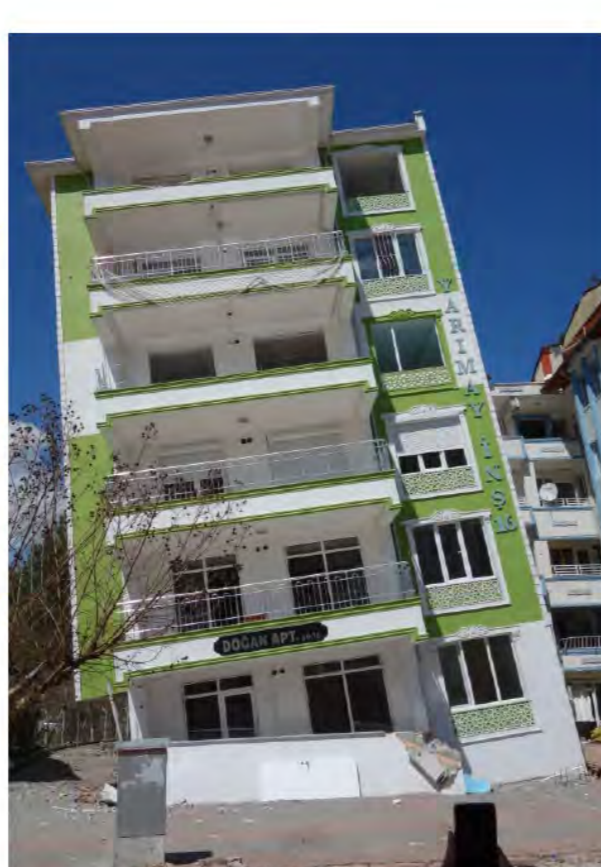
地震による倒壊建物と柱の破壊 傾斜した建物
