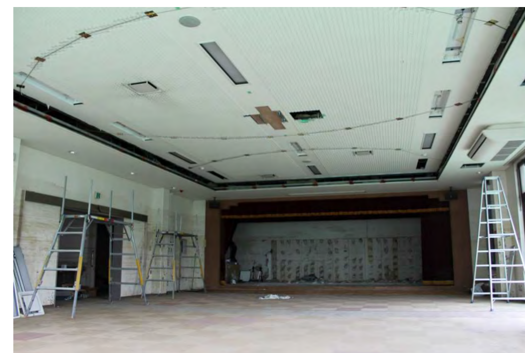
ケーブルによる天井の補強
