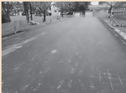
路面下に20個の空洞を設置した実物大試験道路 (30m×6m)
